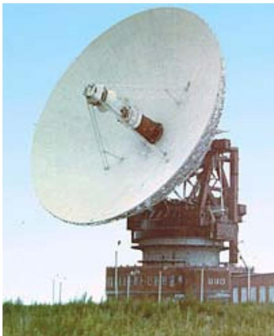
Рис.1. Антенна РТ-70 под Уссурийском с диаметром главного зеркала 70 м.
